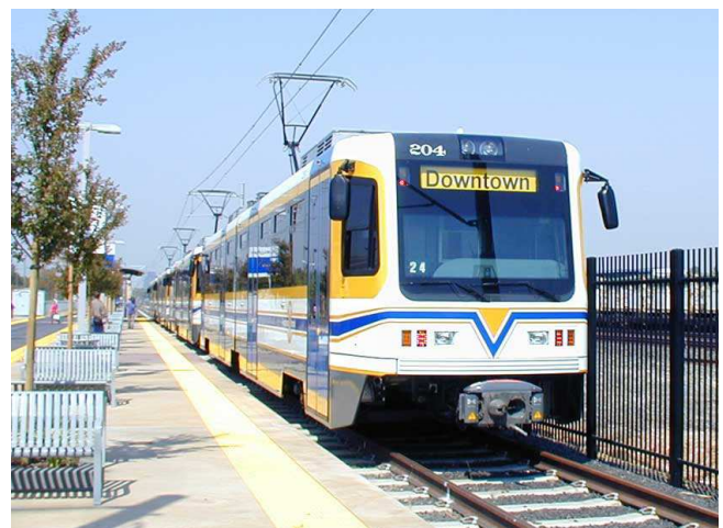
Cung cấp điện bằng thanh ray đặt phía trên đoàn tàu
