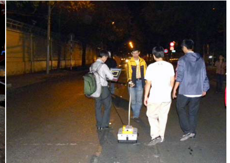
Tim kiếm hố tử thần bằng radar xuyên đất trên đường Hai Bà Trưng, Q.1, Tp.HCM
