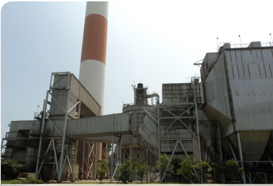
Thiết bị lọc bụi tinh điện tại nhà máy nhiệt điện Phả Lại
