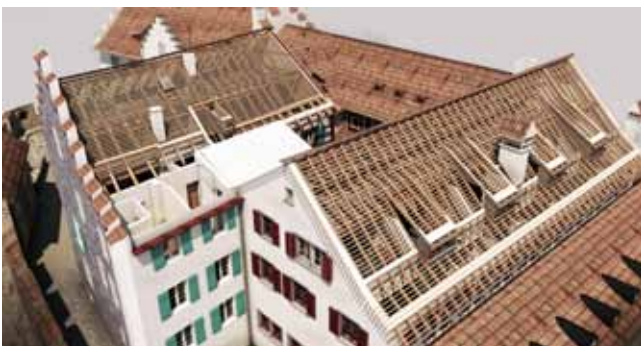
Ảnh chi tiết mái của công trình.
