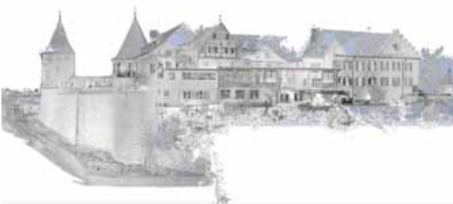
Ảnh quét 3D của công trình.
