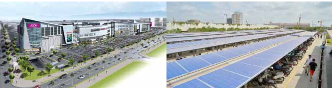
Hệ thống phát điện sử dụng NLMT trên mái che khu vực giữ ô tô, xe máy tại siêu thị Aeon. Nguồn: Aeon.
