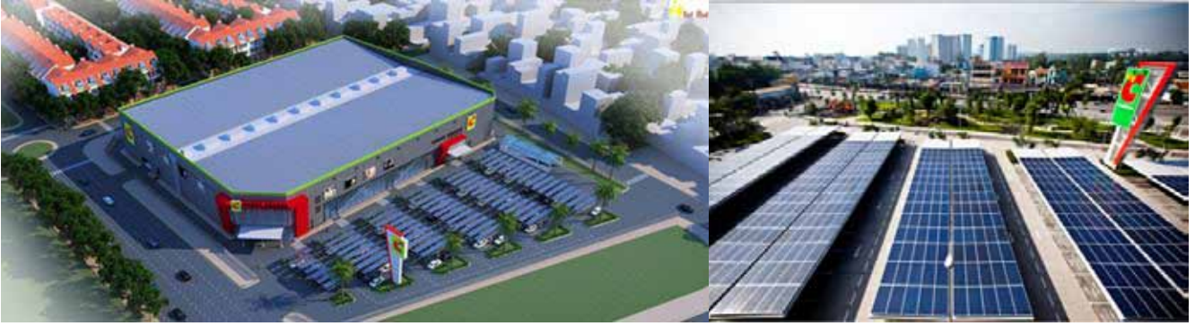
Hệ thống phát điện sử dụng NLMT trên mái che khu vực giữ ô tô, xe máy tại siêu thị Big C. Nguồn: Big C.
