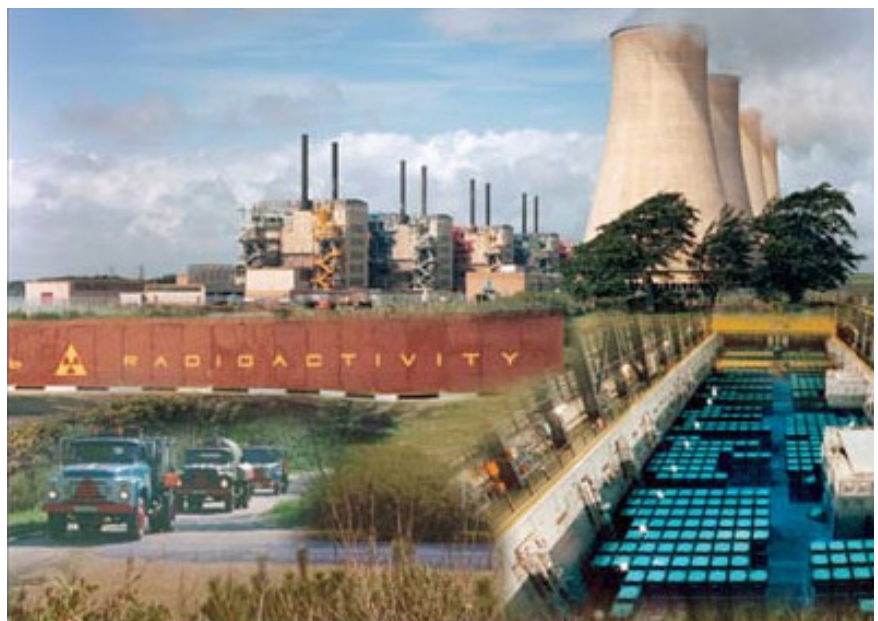
Một nhà máy điện hạt nhân được IAEA hỗ trợ kỹ thuật
